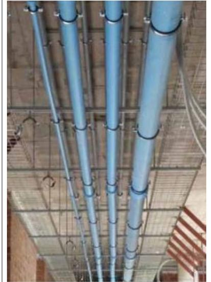
Esempio di lettura: Tubo monostrato,  $L=10\text{m}$ ,  $\Delta T=40\text{K}$ , si espande o si contrae di 60mm (●)
